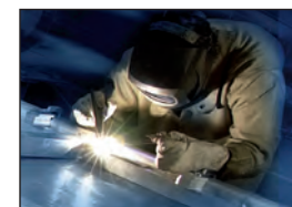
Идеальная TIG сварка на монтаже
